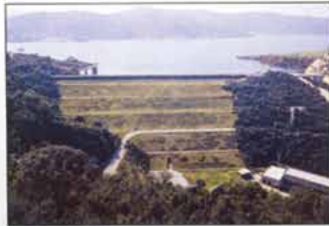
شکل ۲۹: در تقابل با عکس ۲۴ ، مقایسه سطح پایین دست برای مخفی نمودن مغایرت با محیط زیست و درختان نسبتاً انبوه سد « گوادارانکو » ، اسپانیا (سد ها / Presas : Dragados و ساختمانی ها. A. S. ۱۹۷۳)
