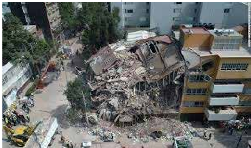
شکل ۲- تخریب ساختمان در زلزله ۲۰۱۷ مکزیک
