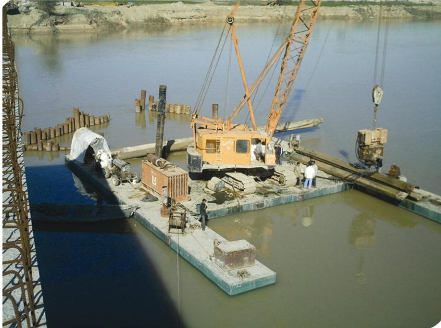
بارج مدولار رودخانه ای روی رود کارون جهت احداث پل محور نظامیه- میاندشت
