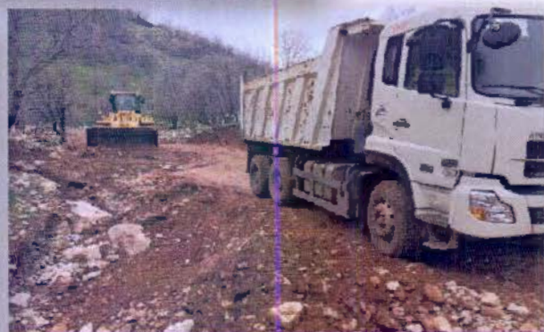
احداث راه دسترسی از آزادراه به معمولان
