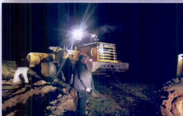
احداث راه دسترسی معمولان به آزادراه (کار در شب)
