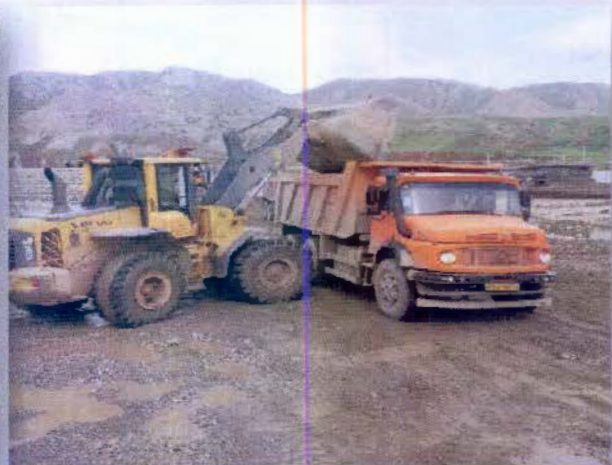
بازسازی پل دسترسی به روستای دسرود افرینه
