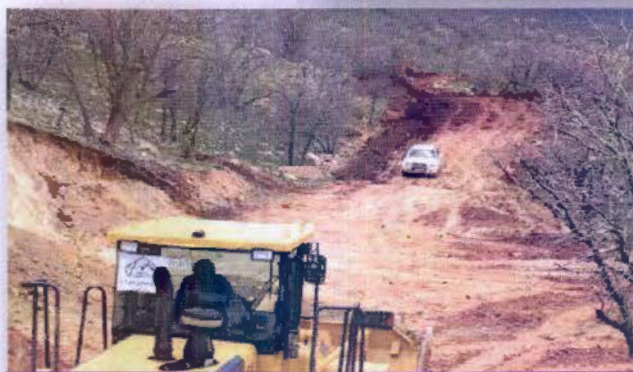
احداث راه دسترسی از آزادراه به معمولان
