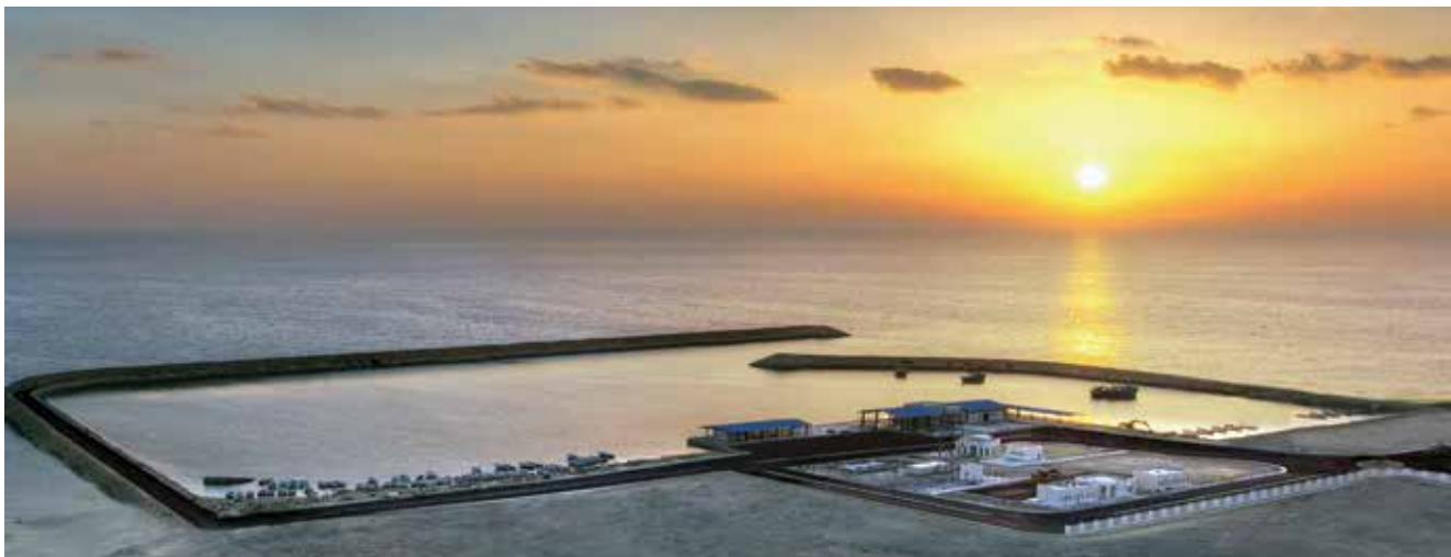
▲ پروژه احداث اسکله دستک رسوبگیر و راه دسترسی به بندر صیادی زرآباد- شرکت پارس تکنو
