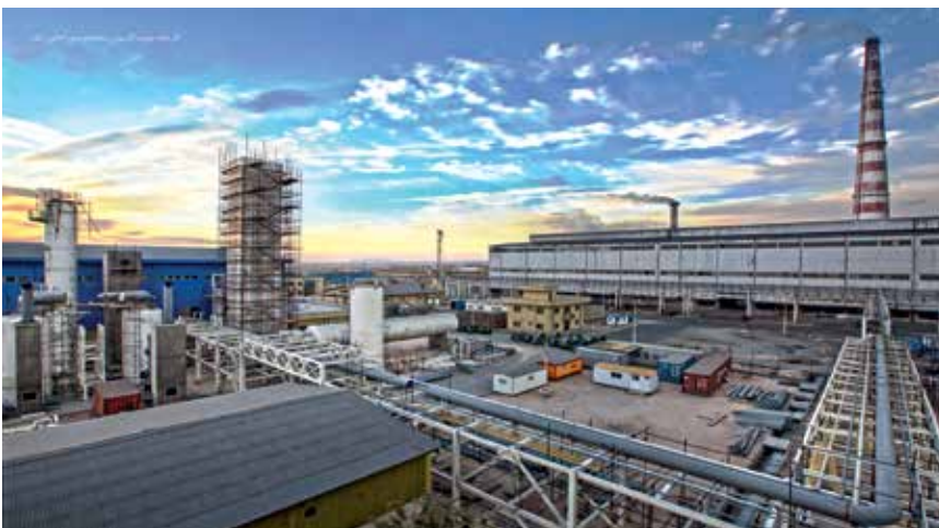
کارخانجات تولید اکسیژن مجتمع مس خاتون‌آباد
