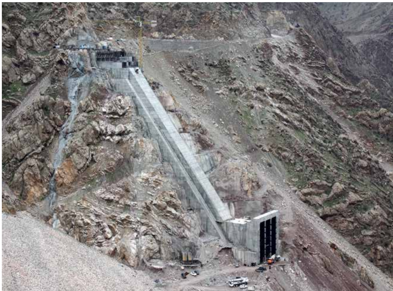
سازه ورودی تونل آب بر سد داریان-شرکت ناودیس راه
