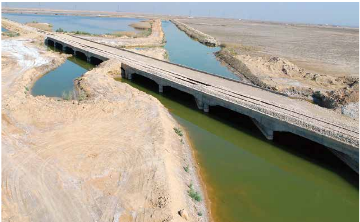
پل اهواز- شرکت ناودیس راه
