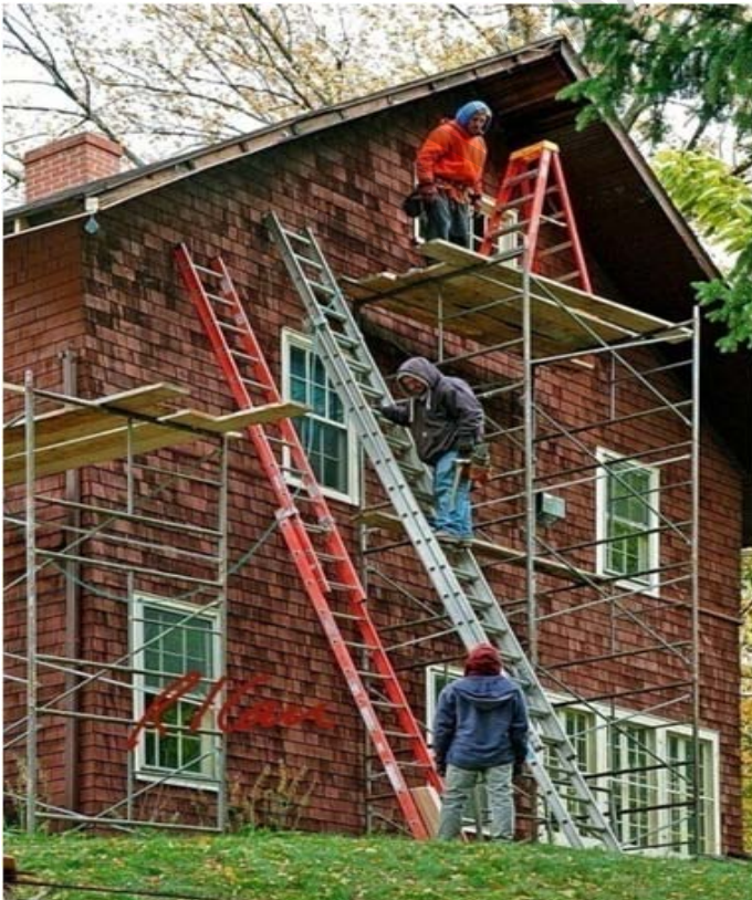
شکل ۲۷- تکیه استقرار نردبان در شیب زمین
