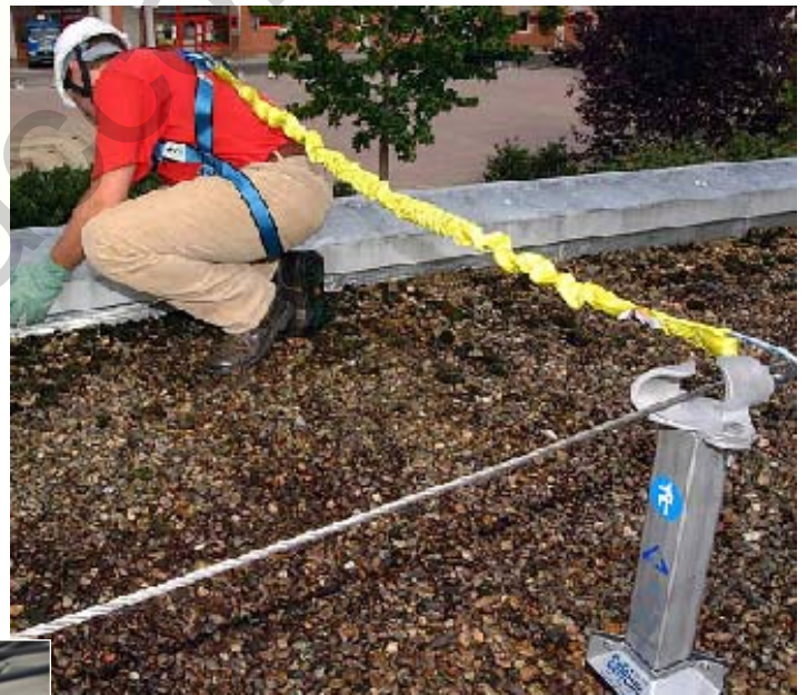
شکل ۵۴-۲- محدود کننده با اتصال یک طناب
