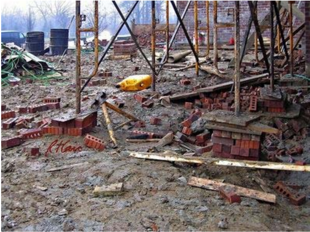
رفتار نایلین در نصب پایه های داربست
