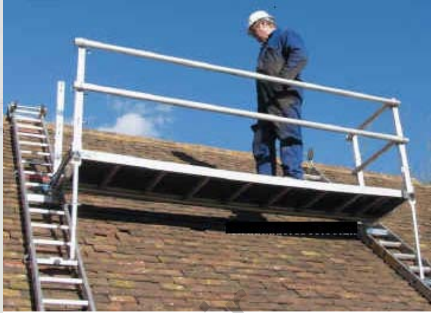
شکل ۳۰- جایگاه کار روی سطوح شیبدار
