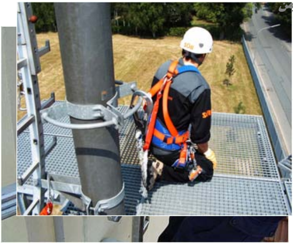
شکل ۱۱۱ - سامانه محدود کننده با استفاده از ریل
