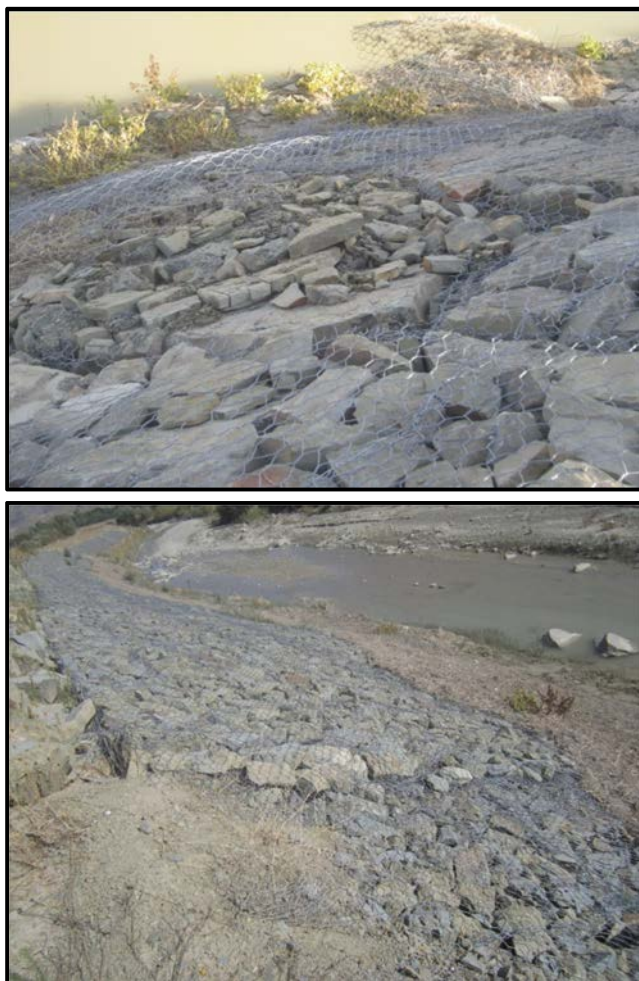
شکل ۴-۱- نمونه‌هایی از رخداد خرابی در توریسنگ‌ها
