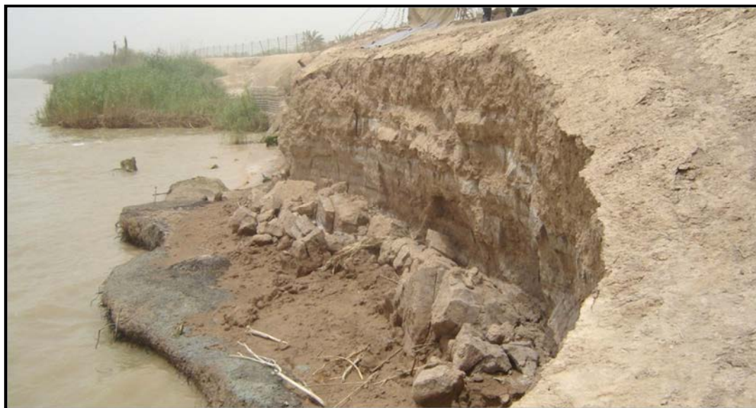
شکل ۲-۲- نمونه‌ای از رخداد پدیده ریزش کناره رودخانه
