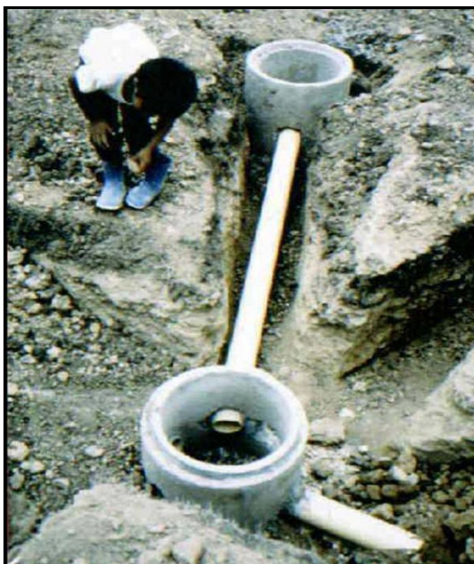
شکل ۲-۲- نمونه‌ای از آدم‌روهای شبکه فاضلاب ساده شده
