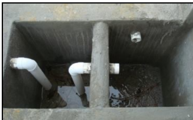
شکل ۲-۵- نمونه‌ای از محفظه (باکس) مانع‌دار در ورودی انشعاب ساختمان به شبکه ساده شده
