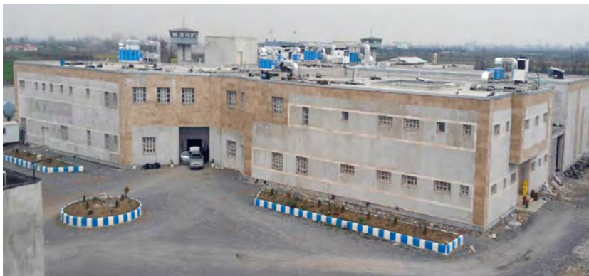
پروژه احداث و اجرای بسترسازی و هسته مرکزی ندامتگاه ۵۰۰ نفره آمل
