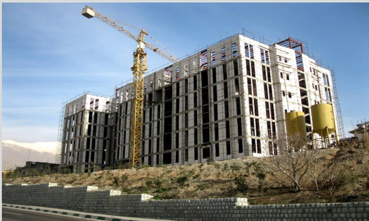
کارگاه مجتمع قضایی جنایی تهران
