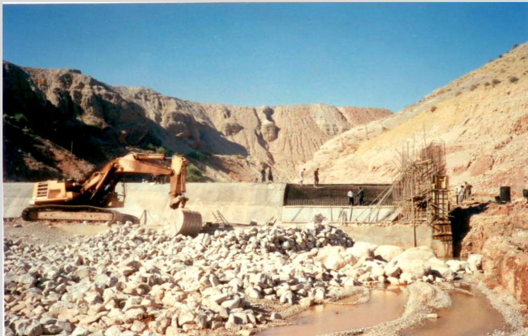
احداث سد بتنی - انحرافی امیرآباد ایلام
