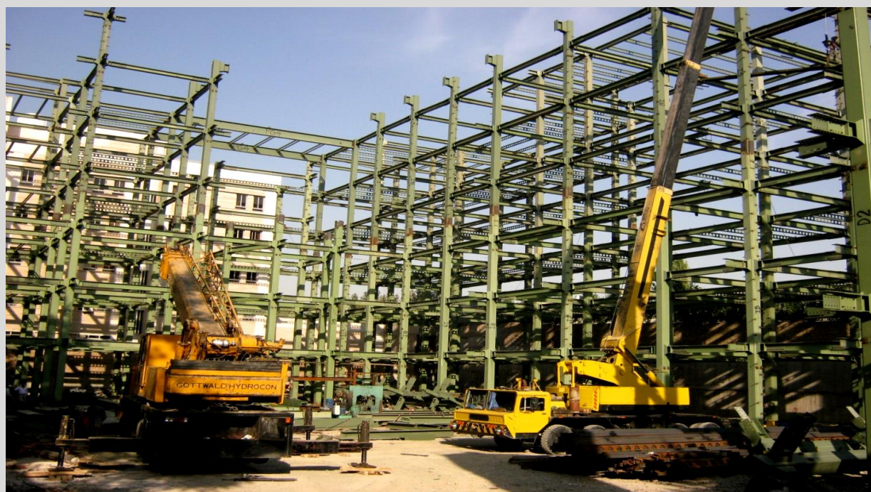
کارگاه مجتمع قضایی خانواده و اطفال تهران
