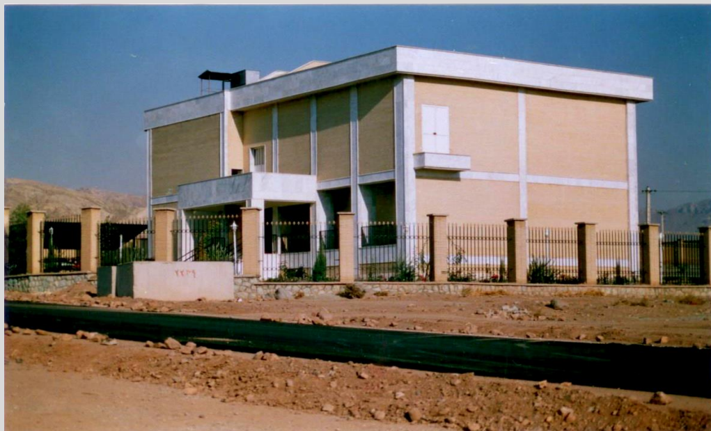
ساختمان مخابرات شهرک صنعتی - خدماتی خاوران
