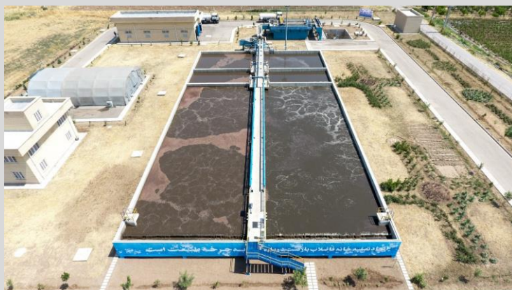
تصفیه خانه فاضلاب شهر محمود آباد قزوین
