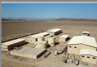
نیروگاه ذغالسوز طبس (اولین نیروگاه ذغالسوز در ایران) ورود به ساخت پروژه های نیروگاهی
