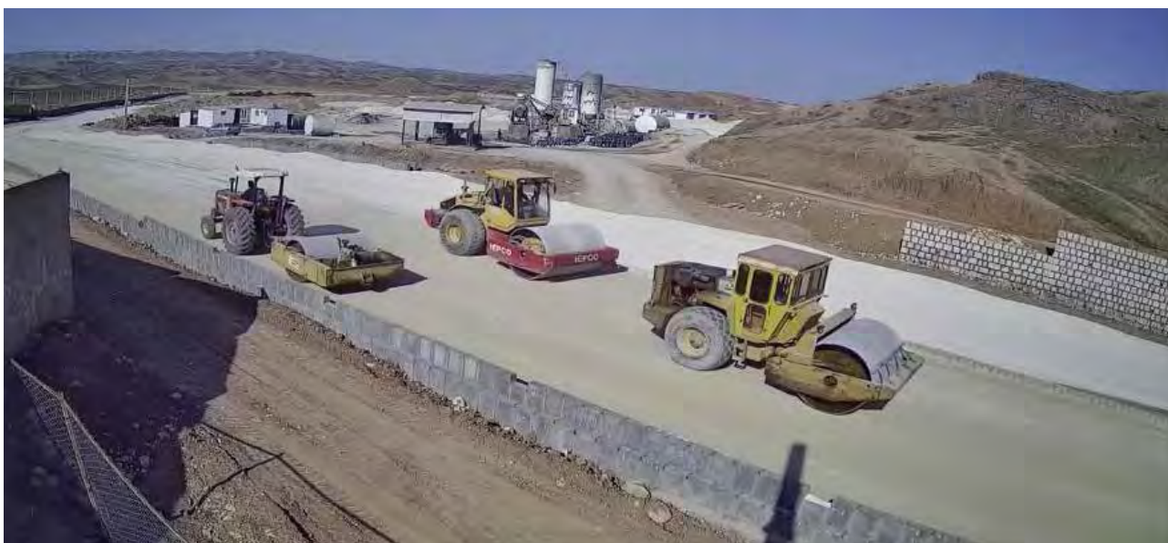
تامین اقلام، آماده سازی و عملیات اجرایی طرح جامع گمرک پرویزخان
