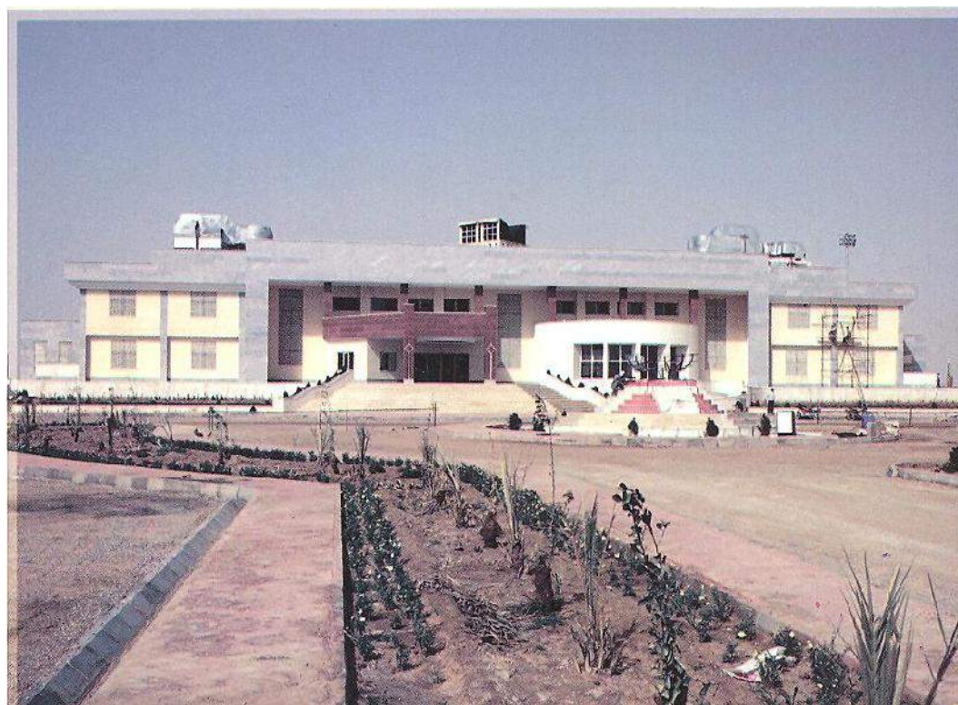
پروژه ایستگاه راه آهن طبس Tabas Train Station
