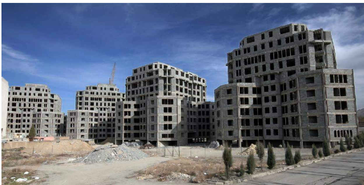
مجتمع مسکونی ۳۲۸ واحدی مخابرات اراک 328 units Residential complex of Arak telecommunication
