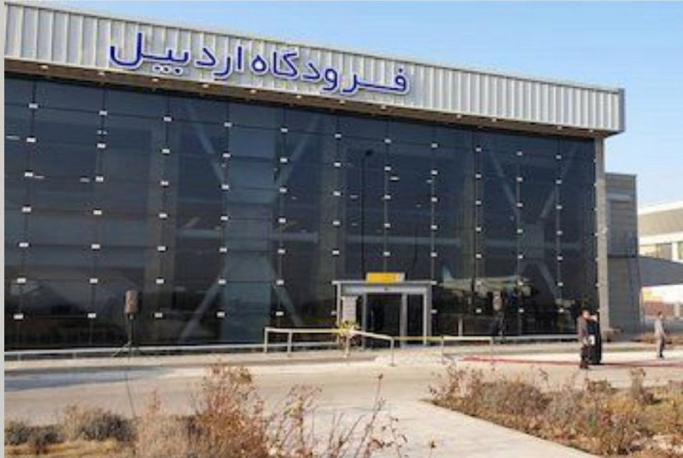
پروژه: ترمینال جدید فرودگاه اردبیل کارفرما: سازمان فرودگاه های کشور
