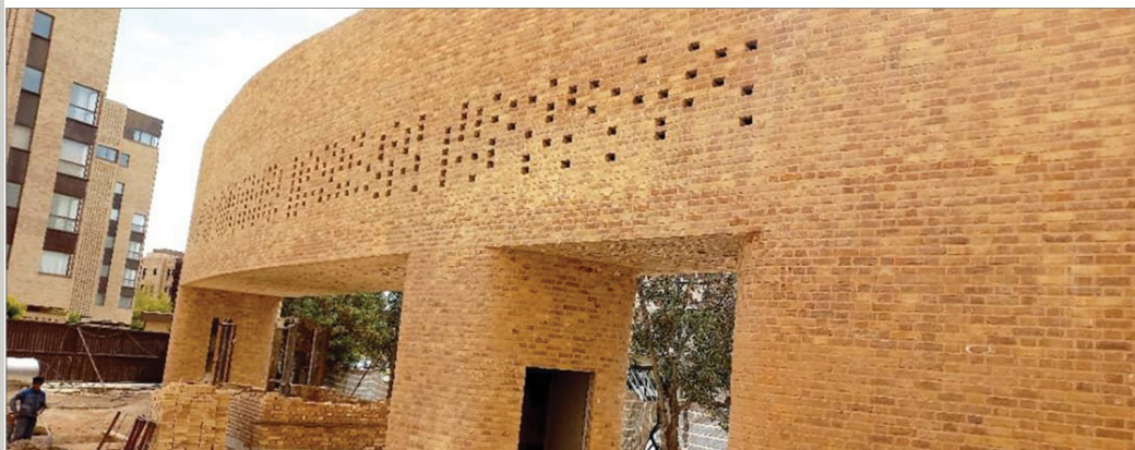
سر در ورودی و نگهبانی مجتمع مسکونی سایه شیراز کارفرما شرکت سرمایه گذاری جنوب
