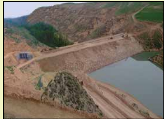
نگاره ۱- نمایی از سد همگن دهشیر زنجان و مقطع تیپ آن (مشاور عمران قرآب)
