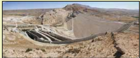
نگاره ۷- ب) نمایی از سد خاکی - سنگریزه ای تالوار. شروع آبیگری (خرداد ۱۳۹۲) (شرکت استراتوس)
