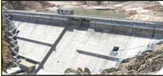
نگاره ۸- نمای از سد بتن وزنی زاوین کلات (نگاره از وب سایت شرکت آب منطقه ای خراسان رضوی)
