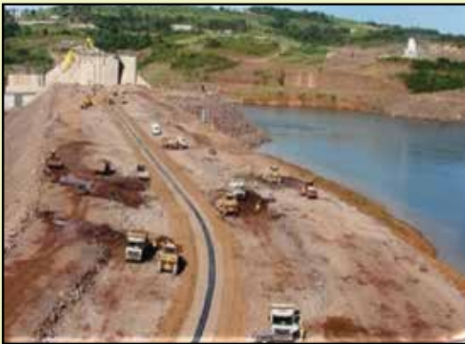
نگاره ۲- دو نما از سد خاکی با هسته آسفالتی در چین (نگاره‌ها از وب سایت شرکت والو (۴۳) سوئیس ۲۰۱۲)
