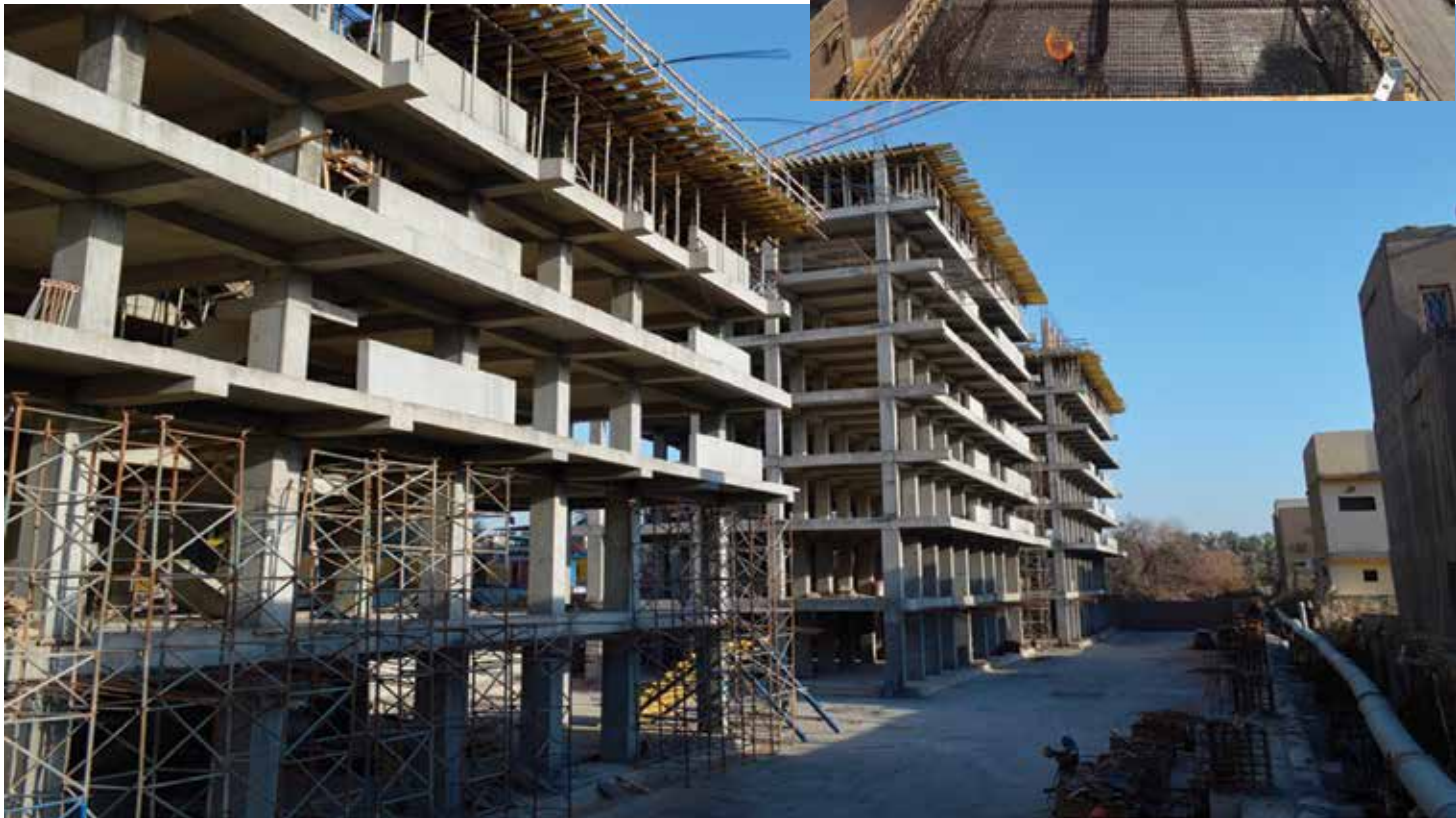
پروژه برج های مسکونی الفردوس کربلا- شرکت بین المللی استراتوس
