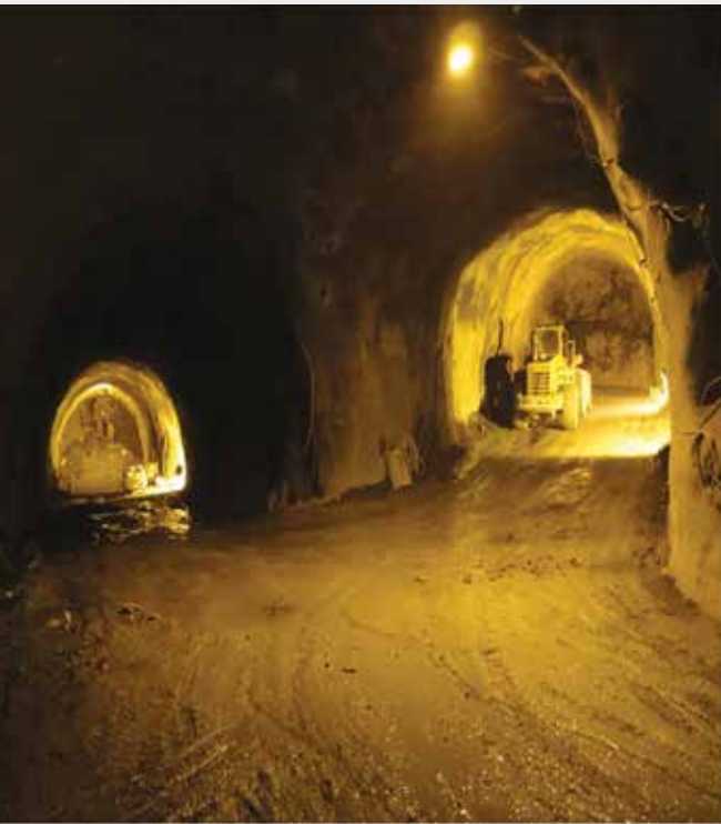
پروژه تونل آب بر نیروگاه تلمبه ذخیره‌ای سد آزاد - شرکت بین‌المللی استراتوس
