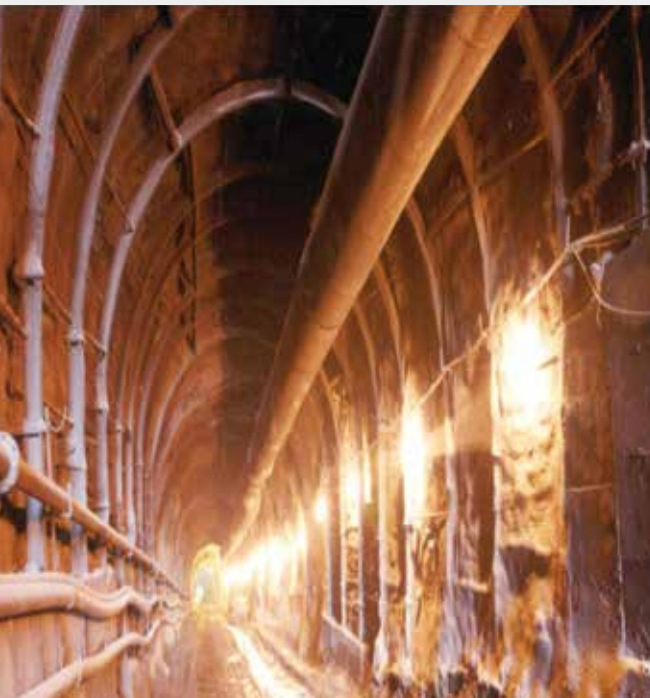
پروژه تونل انتقال آب قمرود - شرکت بین‌المللی استراتوس
