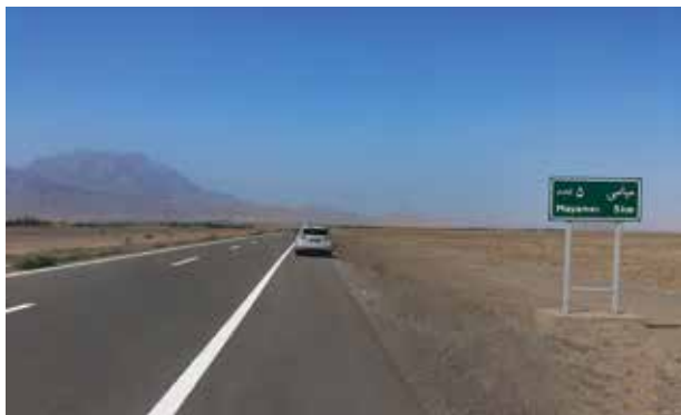
پروژه میامی - جاجرم: این پروژه به طول ۵۰ کیلومتر از سمنان به خراسان شمالی معروف به پروژه میامی - جاجرم اجراء و تحویل گردیده است.
