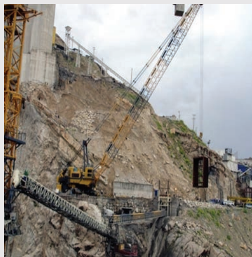
جرثقیل ۳۰۰ تن در حال نصب steel liner
